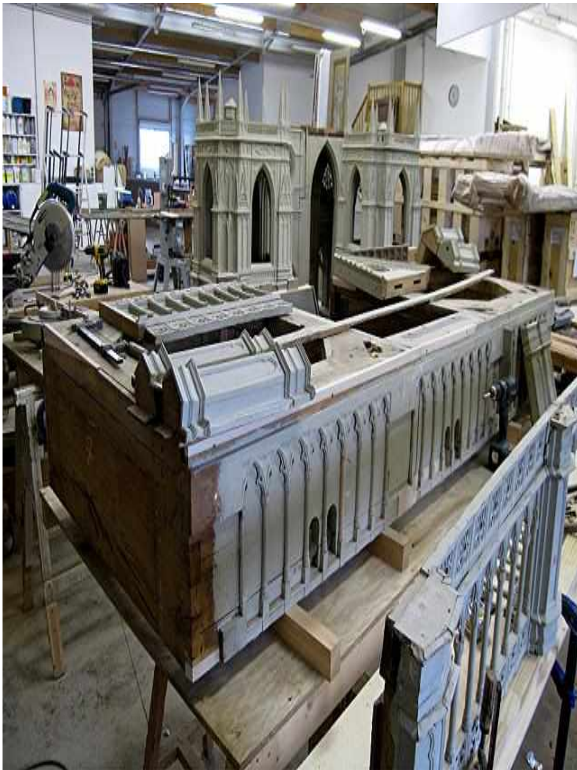
La maquette en cours de restauration aux Ateliers de la Chapelle (Le Longeron, Maine-et-Loire).2/3
