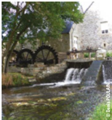
Le moulin de Cuves est un moulin à eau à trois roues situé sur un bief dans la basse vallée de la Sée. Il a été utilisé jusqu'en 1984. Il n'a pas été modernisé et il a conservé tous ses mécanismes, ses trois roues extérieures, ses trois moulins intérieurs, son nettoyeur, sa bluterie, ses monte-charges.
