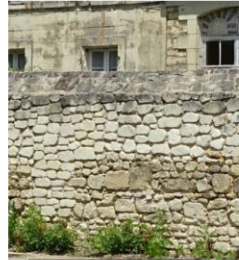
Mur maçonné traditionnel en moellons de calcaire avec chapeau arrondis (moellons hourdis au mortier de chaux)
