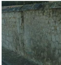
Mur maçonné traditionnel en moellons de calcaire avec chapeau pierre de taille (forme trapézoïdale) débordante
