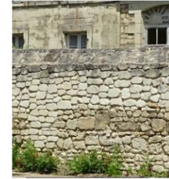
Mur maçonné traditionnel en moellons de calcaire avec chapeau arrondis (moellons hourdis au mortier de chaux)
