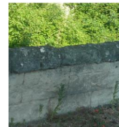
Mur bahut maçonné traditionnel en pierre de taille (calcaire) surmonté d'un chapeau de pierres de taille arrondies
