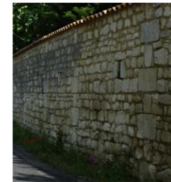
Mur maçonné traditionnel en moellons de calcaire assisés avec chapeau en tuiles canal scellée sur mortier de chaux
