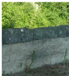
Mur bahut maçonné traditionnel en pierre de taille (calcaire) surmonté d'un chapeau de pierres de taille arrondies
