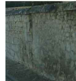
Mur maçonné traditionnel en moellons de calcaire avec chapeau pierre de taille (forme trapézoïdale) débordante
