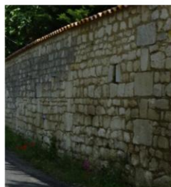
Mur maçonné traditionnel en moellons de calcaire assisés avec chapeau en tuiles canal scellée sur mortier de chaux
