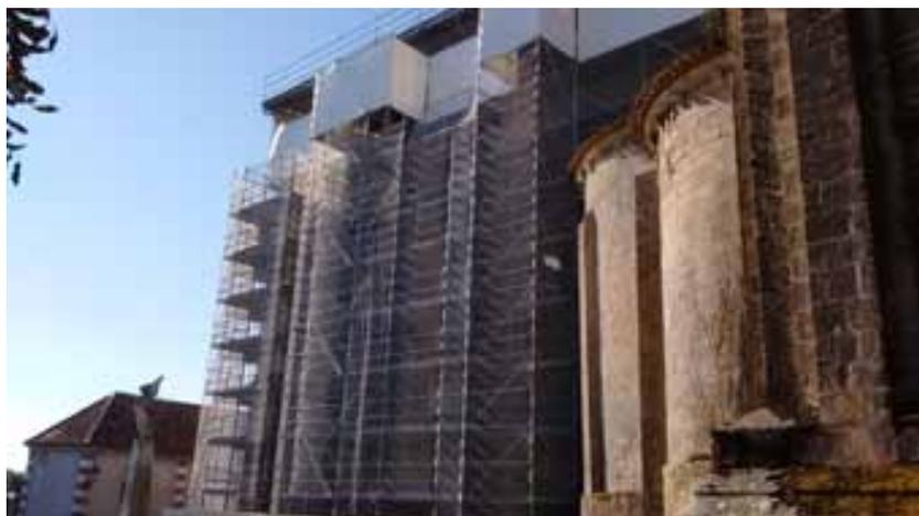
■ **Phase 2** : suite de la restauration du chœur (échafaudages extérieurs et intérieurs), enlèvement de la végétation, étaitements des baies, traitement et nettoyage des parements extérieurs, rejointoiement et enduits, fourniture et pose d'une charpente en sapin neuf, fourniture et pose de tuiles creuses vieilles, grillage anti-volatiles, dépose des vitraux.
