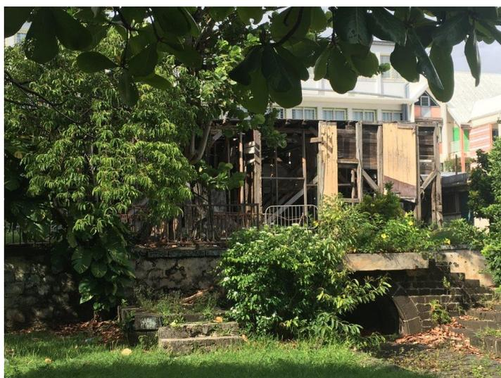
Le 24 décembre 2015, la maison très fragilisée par un manque d'entretien, l'action des insectes xylophages et par les infiltrations récurrentes s'est effondrée. Les dégâts ont emporté la toiture, une partie du premier étage et du rez-de-chaussée.
