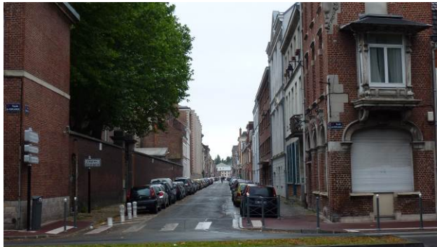
6. Rue Princesse : pavés sur les trottoirs, enrobé sur les stationnements et la bande roulante
