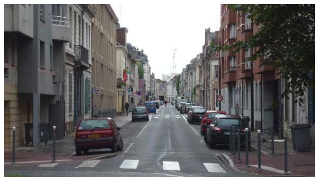
1. Rue Négrier : pavés sur les trottoirs, enrobé sur les stationnements et la bande roulante
