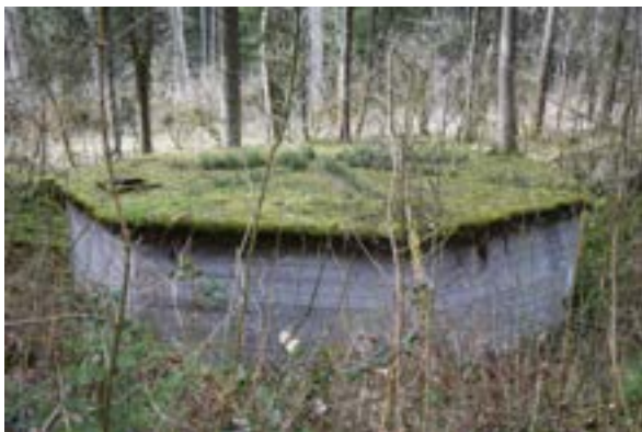
Abb. 2: Der Öltank im Wald. Reste des Ölschieferwerks „Wüste 10“ im Eckerwald bei Schömberg-Schörzingen © B. Hausmair/LAD
