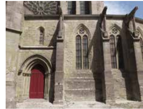
Vue extérieure de la chapelle dite de Guillaume Radulphe, mur sud.
