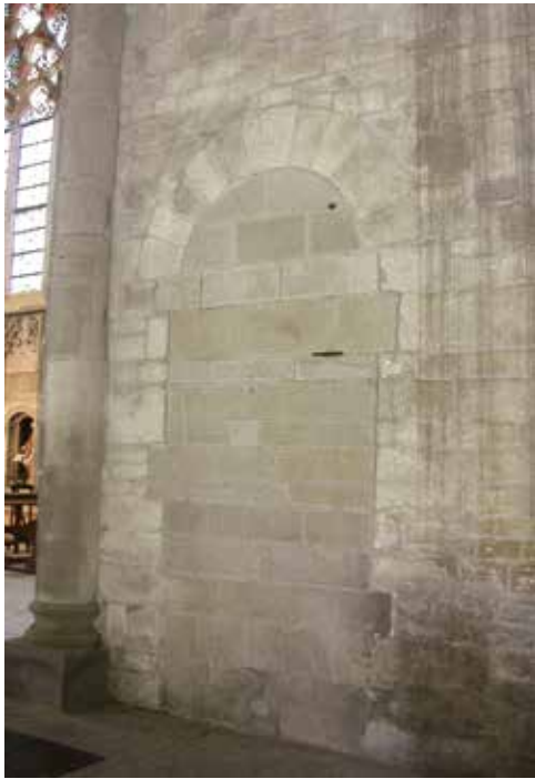
Ancien accès muré de l'escalier du dortoir, bas-côté sud, 4 e travée.
