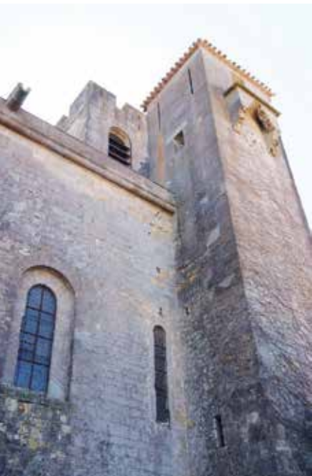
Vue extérieure des parties hautes du bas-côté nord et de la tour d'escalier de la façade ouest.
