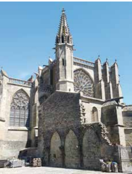
Vue des vestiges de la galerie orientale du cloître, mur ouest de la sacristie.
