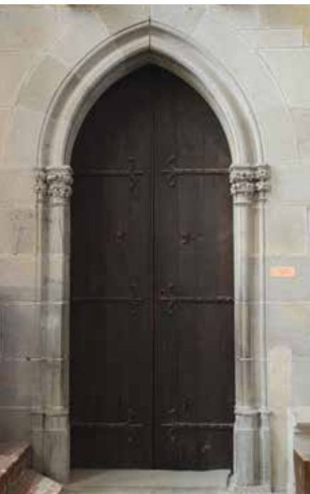
Porte d'accès à la chapelle dite de Guillaume Radulphe depuis le bras sud, création de Viollet-le-Duc remplaçant une porte des années 1500.
