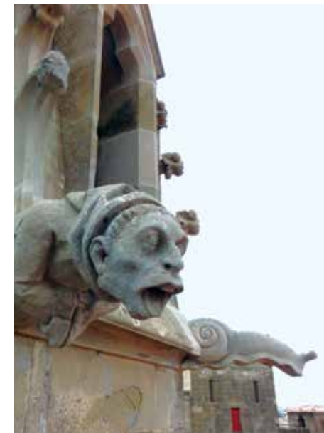
Gargouilles drolatiques dessinées par Viollet-le-Duc, tourelle d'escalier sud.
