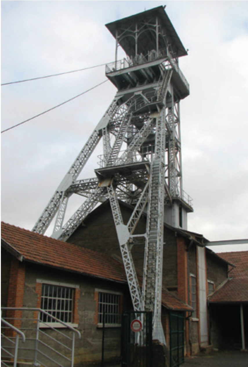
[6] Chevalement d'acier du puits Perret (1920-1928) à Saint-Pierre-La-Palud. Au premier plan, vue du bâtiment de la recette où arrivait le minerai de pyrite de fer, également exploité pour son soufre.
