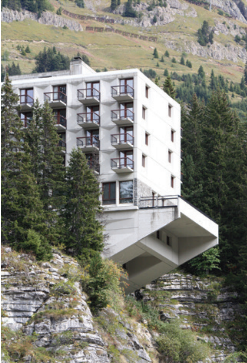
[4] L'hôtel Le Flaine (1967) et sa terrasse sud en porte-à-faux sur la falaise. Les immeubles de la station ont été construits en préfabrication lourde selon le procédé de Baretts et les matériaux acheminés sur le chantier par téléphérique.
