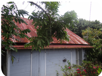
Case en bardage bois peints sur la façade principale sous tôle peint rouge minium (anti-rouille), Saint-André
