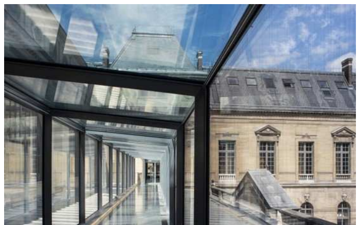
Richelieu phase 1. Aménagement, bâtiment : Atelier Bruno Gaudin.
