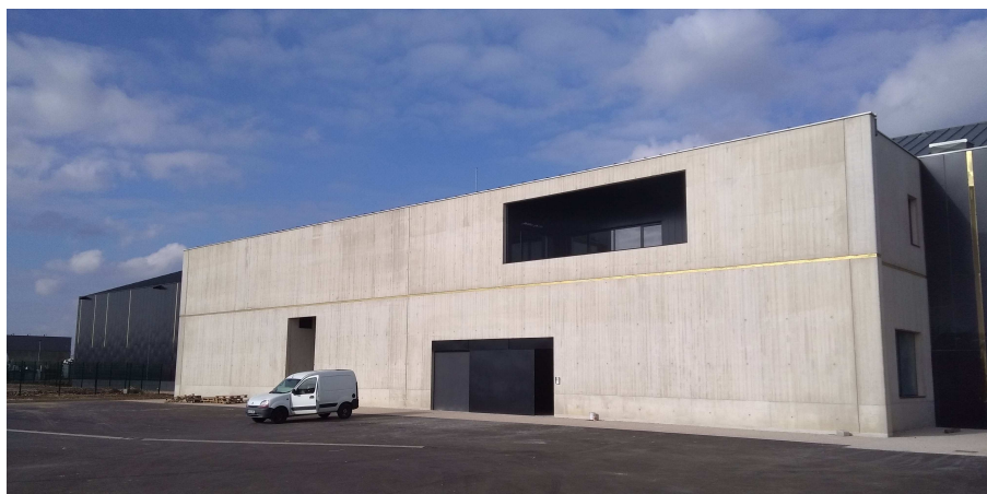
Le nouveau Centre de conservation et d'étude de Lorraine © Tanguy Le Boursicaud
