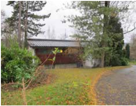
Haute-Saône (70) – Vesoul MAISON PETITPERRIN 1964-1965 67, rue Saint-Martin Jean Petitperrin, architecte Labellisé « Patrimoine du xx e siècle » le 16/10/2014 Cette petite maison très simple exprime bien l'influence de l'architecture nordique et plus particulièrement celle d'Alvar Aalto dans les années 60 en France. Elle met en œuvre une organisation spatiale intérieure à la fois très fluide mais chaque lieu de vie est parfaitement bien identifié grâce à la position des fenêtres ou l'usage de matériaux différents. À l'extérieur, c'est une maison ancrée au terrain naturel, orientée de façon à bénéficier de la vue et de l'ensoleillement et qui reprend les mêmes principes de fluidité par l'absence de clôture tout en indiquant clairement la limite entre public et privé. La mise en œuvre de matériaux différents répond à l'usage interne de la construction (béton pour le rez-de-jardin où se trouve l'agence d'architecture et bois et verre pour l'étage abritant les espaces de vie). Béatrice Rénahy
