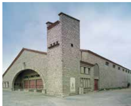
Aude (11) – Saint-Nazaire-d'Aude CAVE COOPÉRATIVE VINICOLE 1951 Chemin de Narbonne René Villeneuve, architecte Labellisé « Patrimoine du xx e siècle » le 14/02/2013
