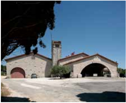
Gard (30) – Tavel CAVE COOPÉRATIVE VINICOLE 1937 ; 1964 Route de la Commanderie Henri Floutier, architecte ; Sculpteur : Armand Pellier IMH (arrêté du 11/06/2013)
