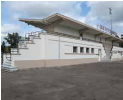
Haute-Saône (70) – Luxeuil-les-Bains STADE 1936-1938 39, rue du Maréchal-Turenne Paul Giroud, architecte Labellisé « Patrimoine du xx e siècle » le 16/10/2014 Architecture au dessin rigoureux, dans la continuité de la production architecturale des années vingt comme celle de Robert Mallet-Stevens par exemple. Cette tribune présente côté public, une façade représentative parfaitement symétrique, constituée de deux corps de bâtiments couronnés par un unique auvent horizontal. Côté stade, c'est l'expression purement fonctionnelle de la structure en porte à faux de l'auvent abritant les spectateurs qui domine. Rénovée récemment, elle a malheureusement perdu le mât en béton très bien dessiné qui marquait son entrée. Béatrice Rénahy
