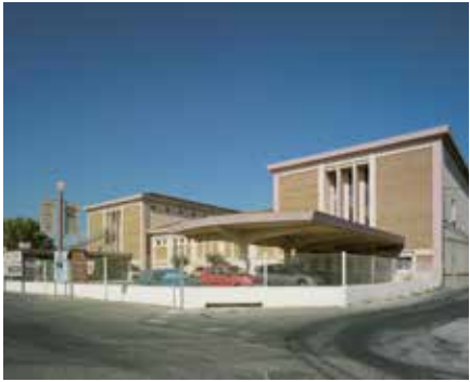
Gard (30) – Vauvert CAVE COOPÉRATIVE VINICOLE DE GALLICIAN 1952 128, avenue des Costières Henri Floutier, architecte Labellisé « Patrimoine du xx e siècle » le 14/02/2013
