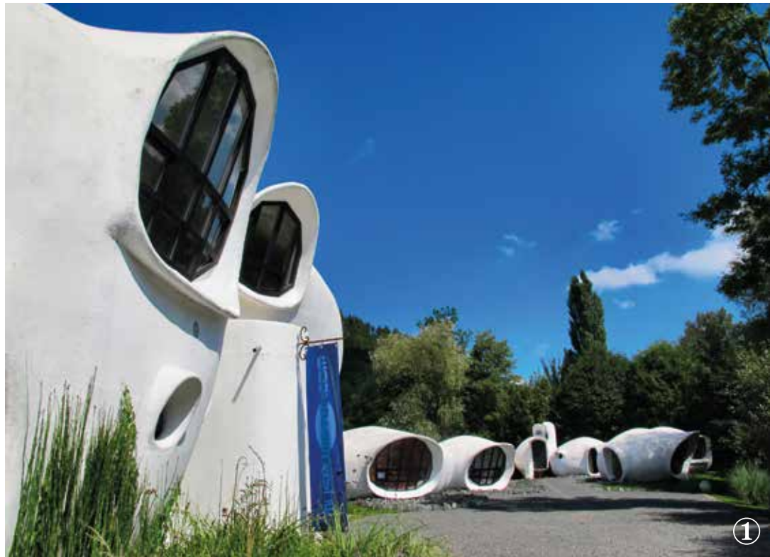
Moselle (57) – Saint-Avold CITÉ MÉLUSINE, MAISONS D'INGÉNIEURS ET IMMEUBLES DE BUREAUX 1947-1949
