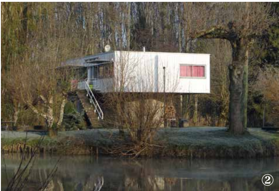
Haute-Saône (70) – Chemilly MAISON KIELWASSER ② 1963-1964 André Maisonnier, architecte Labellisé « Patrimoine du xx e siècle » le 16/10/2014 Cette remarquable maison très « moderne » de André Maisonnier reflète les possibilités offertes par les matériaux comme le métal pour le revêtement des façades ou bien le béton avec la réalisation de la dalle de la maison posée en porte à faux sur son socle ou l'escalier dont la plastique résulte de la nature même du matériau coulé en place. Cette maison est un véritable témoignage de l'importance qu'a eu Le Corbusier sur la conception architecturale dans le monde en général et en Franche-Comté en particulier. Elle reste un exemple unique dans la région. Béatrice Rénahy
