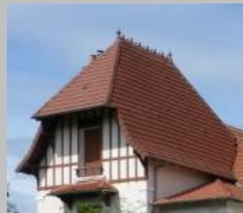
Couronnement de faîtage
