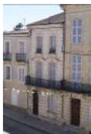
AY150 - 20 rue du Gal Lamarque
