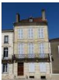
AY146 -18 rue du Gal Lamarque
