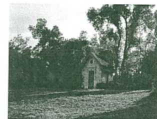
Chapelle (?) datée de 1900 abritant un puits
