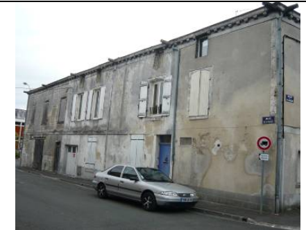
Maison XVII e rue de la Halle
