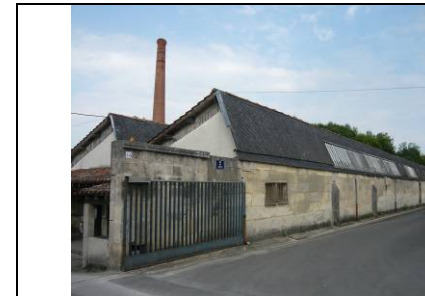
Usine d'emballage et de conditionnement
