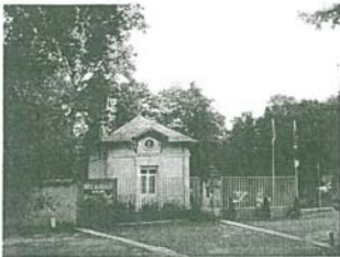
Pavillon de gardien, entrée Ouest
