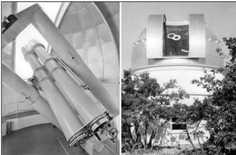
L'observatoire et le télescope du GPO (grand prisme objectif) a été mis en service en 1960. Ce télescope à double lunette dont le diamètre est plus grand que le PPO avec un double prisme rotatif a été créé en 1958. Il est actuellement non utilisé et son instrument déposé.
