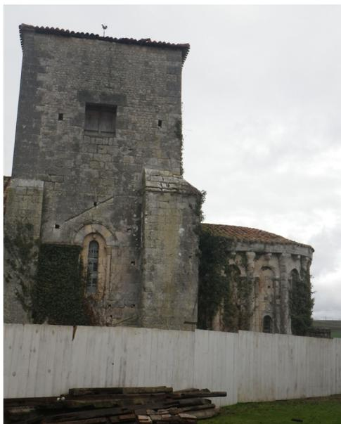
La couverture du clocher sera entièrement reprise en tuiles tige de botte neuves à ergot sur liteaunage en courant et de récupération à pannetonnage cuivre en courant. Le beffroi des cloches nécessitera une vérification de ses assemblages.
