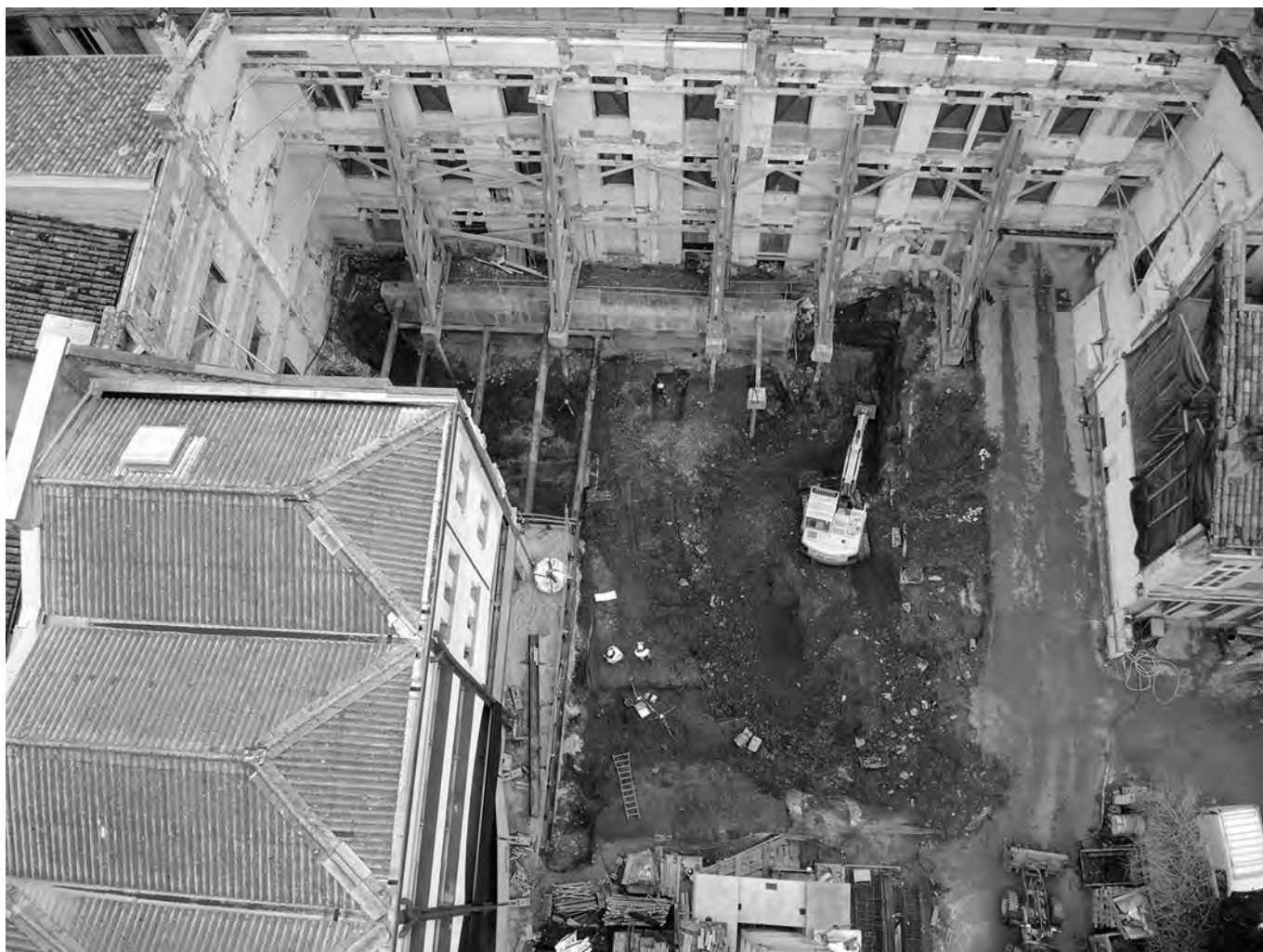
Bordeaux - 7/17 rue Castéja. Vue aérienne du chantier prise depuis une grue (cliché St. Pèveau, SOGGEDA).
