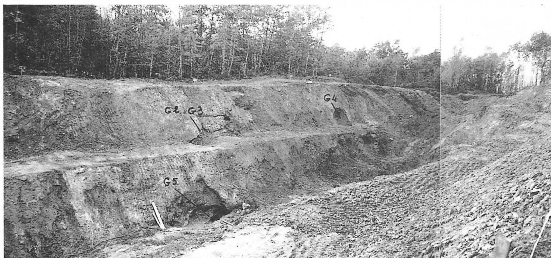
Fig. 2 — Jumilhac-le-Grand : vue sur la partie sud de la mine des Fouilloux en cours de réexploitation et localisation d'entrées de galeries souterraines.
