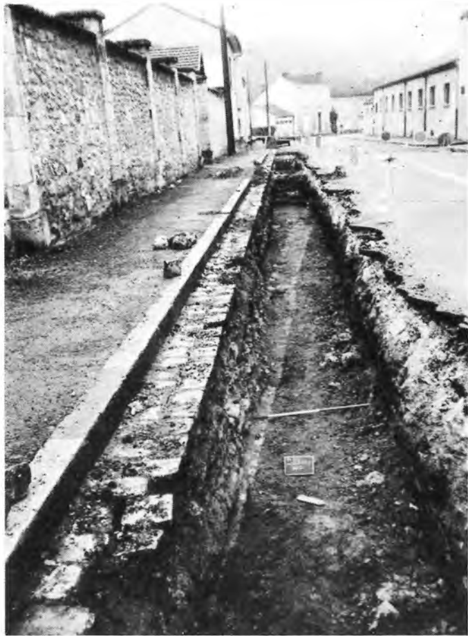
Fig. 3 : Périgueux, rue du 26ème RI, vue de la tranchée
