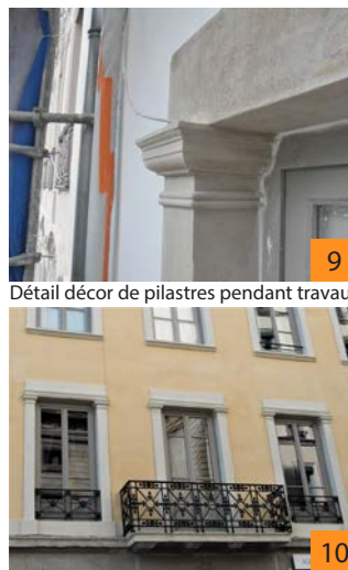
Zoom après travaux
