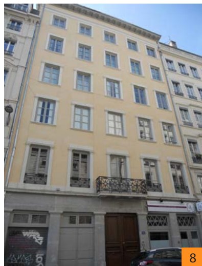
Façade après travaux
