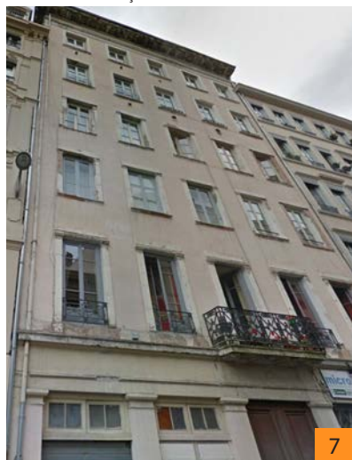
Façade avant travaux
