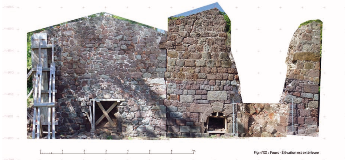
Montage de la façade des fours (M.L. Laharie).
