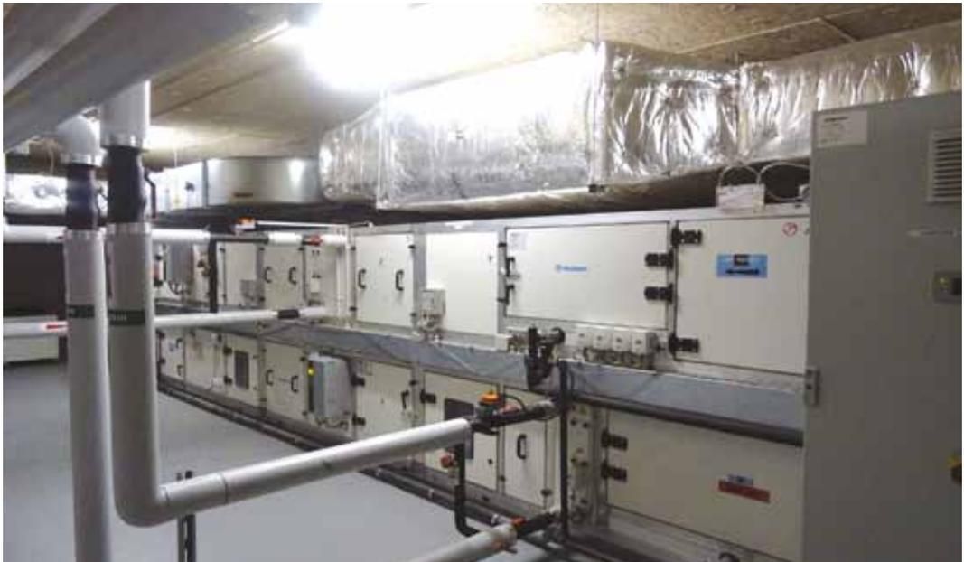
Image 26. Vue de la CTA à dessiccation dans le local technique du sous-sol
