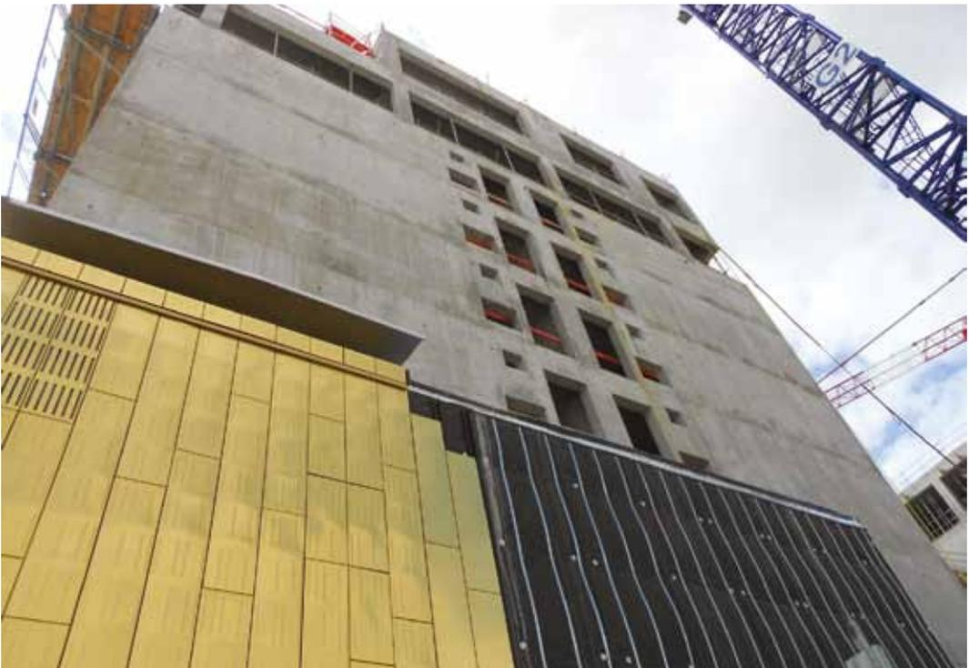
Image 11. Archives départementales du Rhône et de la métropole de Lyon - architectes Gautier&Conquet et Dumetier - isolation thermique par l'extérieur en cours de montage
