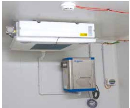
Image 28. Unité à détente directe et déshydrateur dans l'un des magasins à basse température
