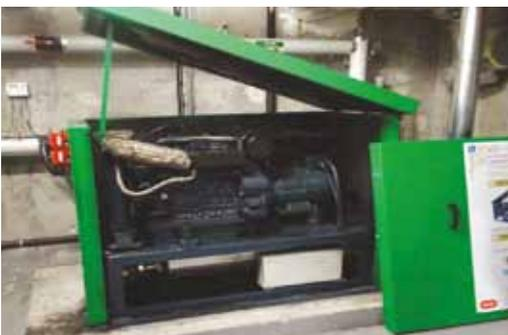
Image 24. Vue de cogénération fonctionnant à l'huile de colza (local technique en sous-sol)
