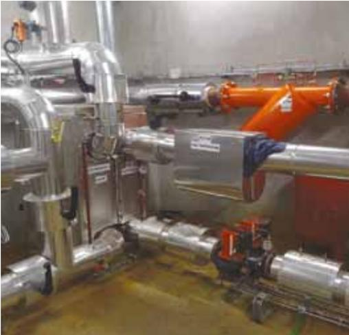
Image 20. Échangeur d'eau rafraîchie et filtration de l'eau du puits
