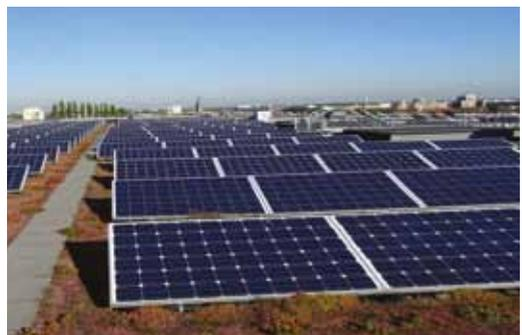
Image 25. Vue partielle des 300 m<sup>2</sup> de panneaux photovoltaïques sur la terrasse végétalisée
