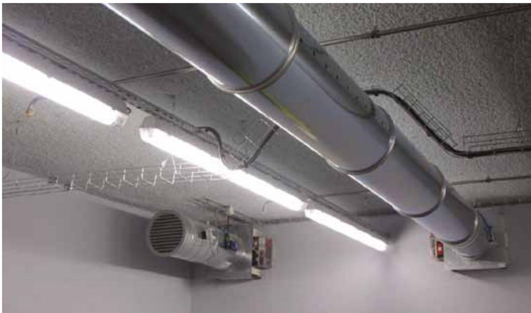
Image 15. Vue d'une gaine de diffusion à très haute induction et d'une grille de reprise d'air
