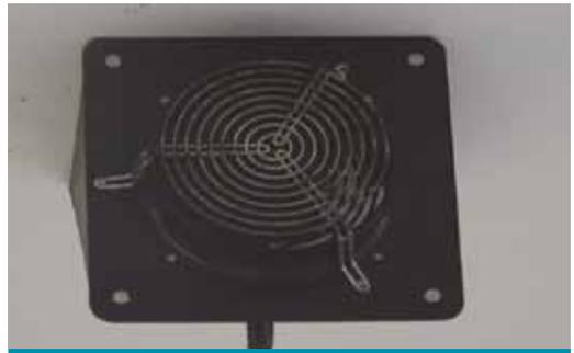
Image 18. Brasseur d'air en plafond des magasins d'un débit de 250 m<sup>3</sup>/h (2 par magasin)
