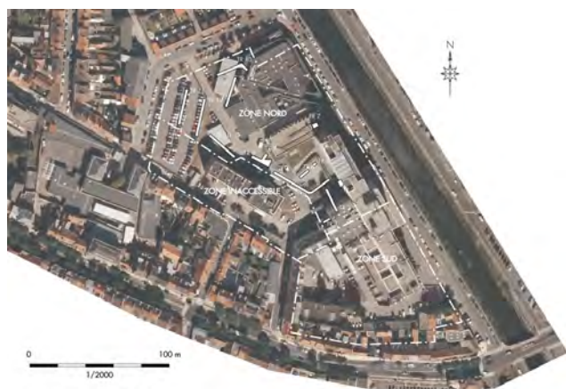
Calais-Nation (Pas-de-Calais) Emprise du diagnostic, phases, tranchées sur la photo aérienne avant démolition.
