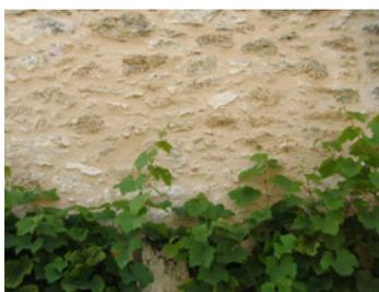
*Exemple d'enduit à pierres vues assurant la liaison entre l'encadrement de la baie et le parement de la maison*
