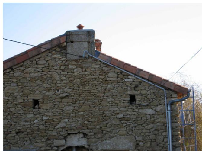
Le recouvrement de la rive par des tuiles mécaniques est à proscrire car il alourdit la silhouette du pignon.
