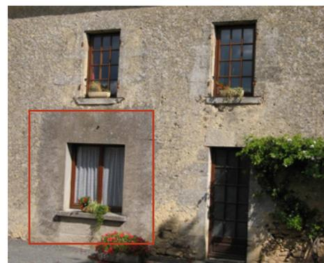
*L'encadrement béton et la proportion carrée de la nouvelle fenêtre sont en rupture avec les autres percements verticaux.*
