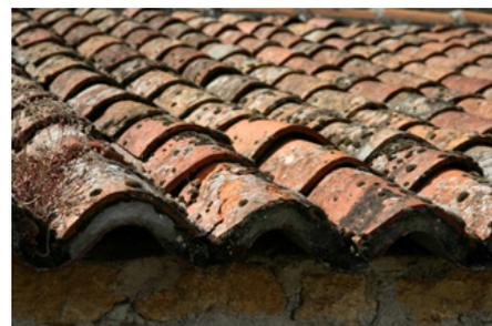
*La tuile canal est scellée par un mortier de chaux en rive de toiture. Autrefois les eaux de pluie versaient directement au pied du mur. Pour des raisons de préservation de la maçonnerie le recours à la gouttière zinc est autorisé .*
