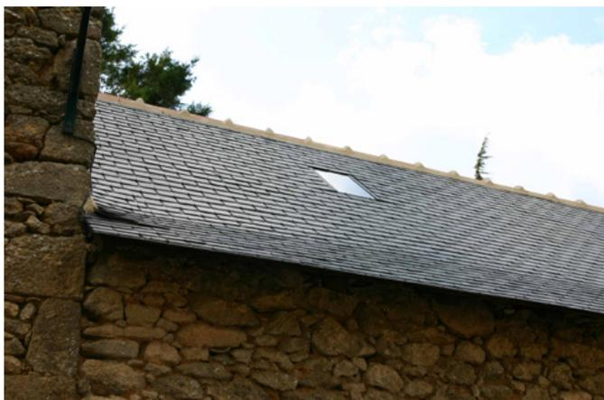
La pose de chassis de toit de petite taille est possible en pose encastrée.
