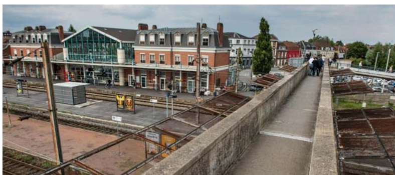
Le pôle gare de Béthune
