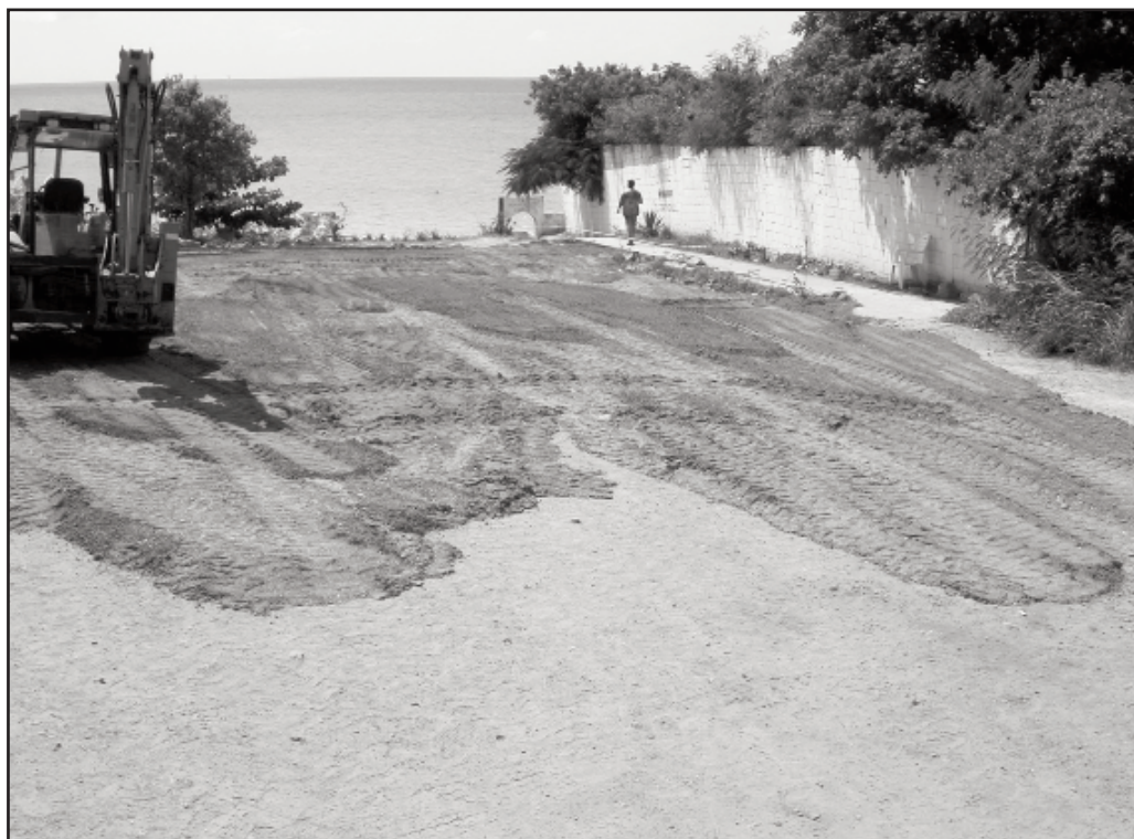
Mise en place du remblai protecteur
