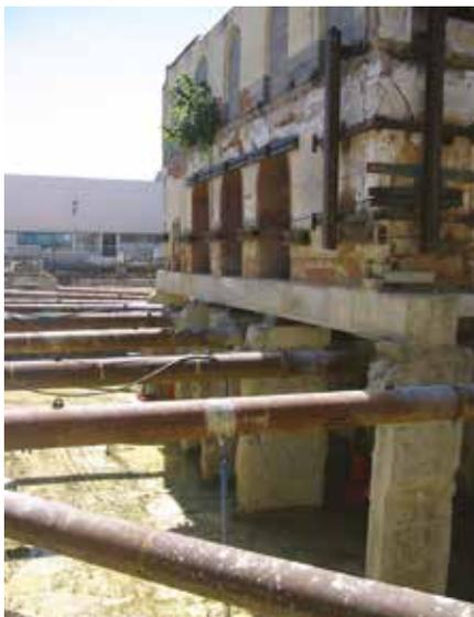
Le creusement de trois niveaux de stationnement au pied des immeubles vétustes de la rue Saint-Rémésy, en partie sous le bâtiment historique, au-dessus du tunnel du métro, dans un site archéologiquement délicat, a nécessité des moyens techniques particulièrement complexes, longuement élaborés, des travaux minutieusement exécutés.
