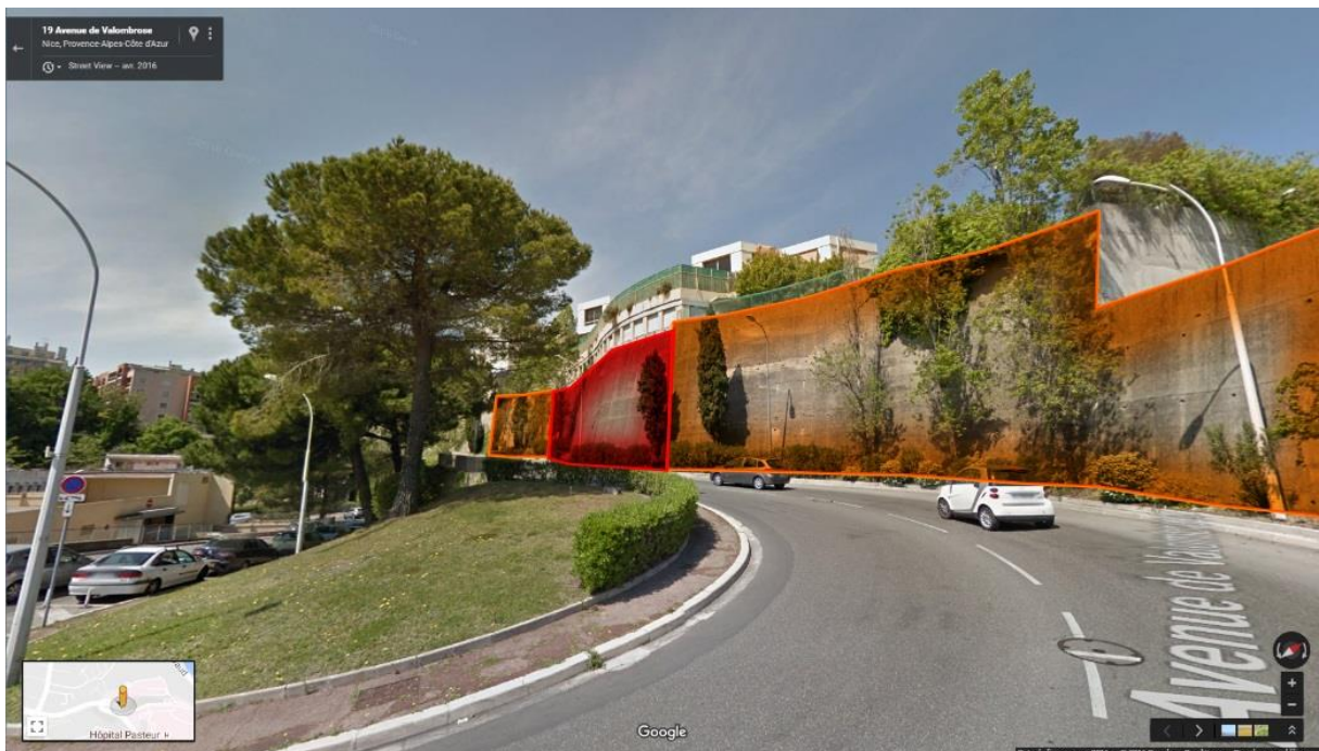
Vues depuis l'Avenue de Valombrose du mur de parement(rouge)/soutènement (orangé), avec le bâtiment K au Nord-Ouest surplombant le dit-mur et l'avenue. Source Google Street view.
