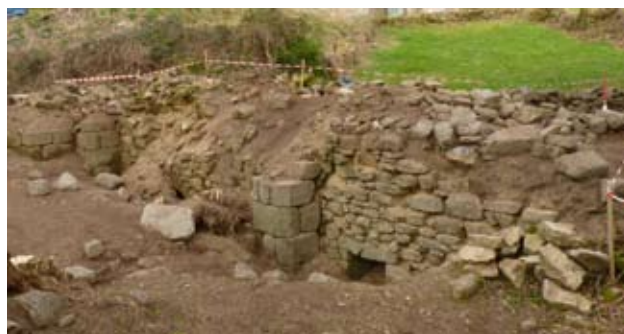
Fig. 1 Mur gouttereau nord de l'église du prieuré de Montaigut en cours de nettoyage. Cliché : Yann Giry ArchéA 2015
