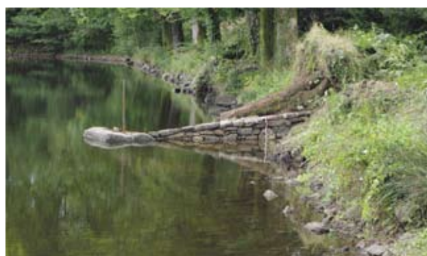
Fig. 2 Rampe d'accès et sommet de la vanne haute de l'étang des Sauvages (cliché O. Bauchet)
