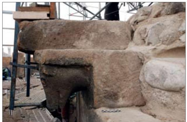
Fig. 2 Modillon et dalles à billettes pris dans la maçonnerie chargeant les reins de la voûte, vue depuis le nord
