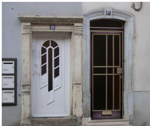
Illustration 6: remplacement de portes d'entrées, induisant une perte patrimoniale et une altération architecturale. Or des solutions efficaces permettant l'amélioration thermique des portes existantes sont possibles
