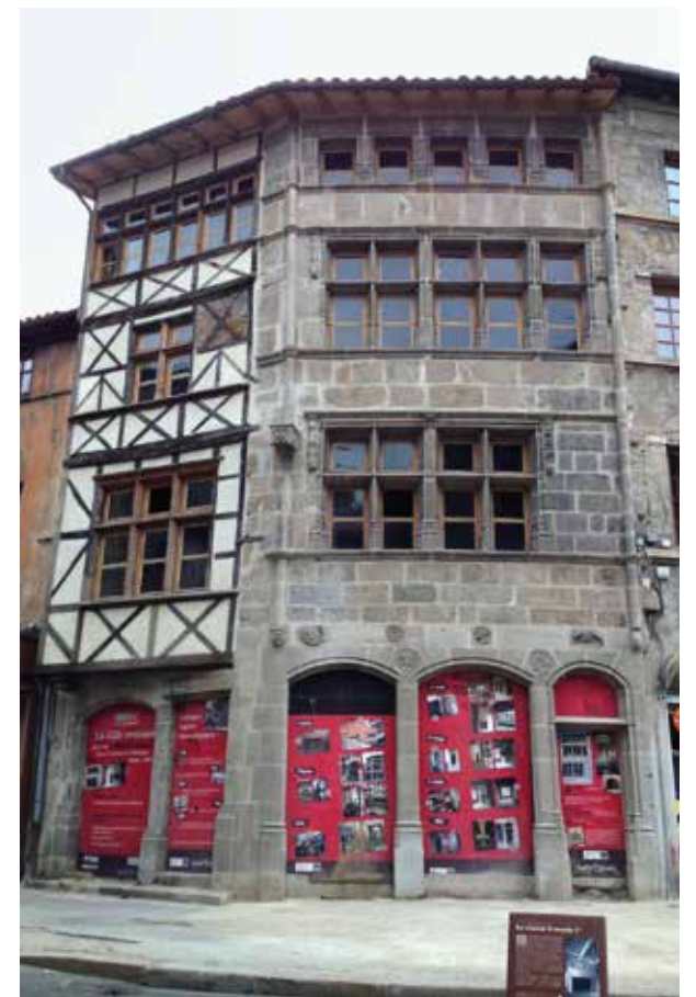
La Maison François I er aujourd'hui, après restauration de la façade sur rue et des menuiseries.
