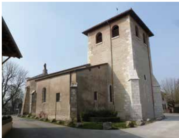
Église de Bouligneux, vue générale extérieure avant restauration.
