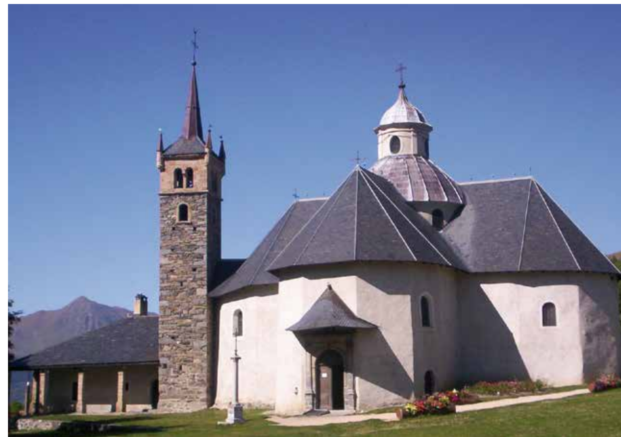
Vue générale extérieure de la chapelle restaurée.
