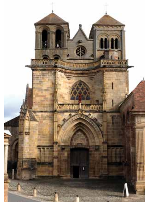
Façade occidentale de l'église prieurale de Souvigny.
