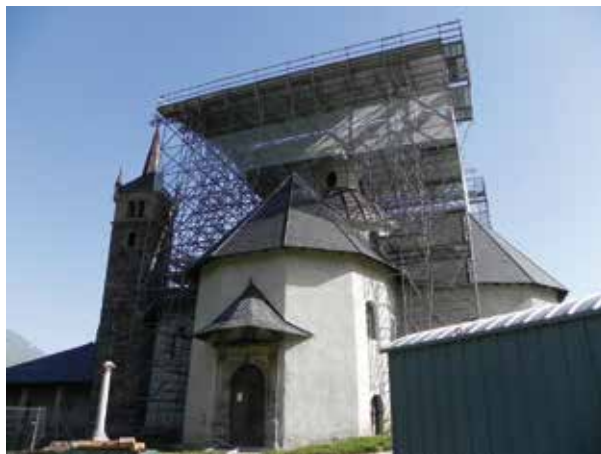
La restauration des parties extérieures de la croisée du transept (toitures, coupole et lanterneau*), protégée par un parapluie*.
