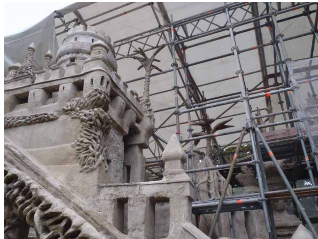
Le Palais en chantier. Un parapluie* protège des intempéries les structures en cours de restauration.
