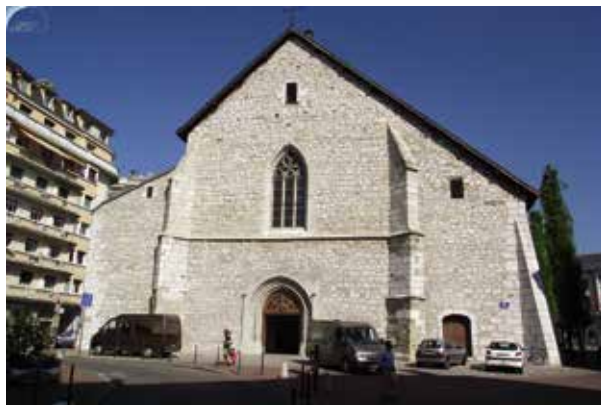
La façade occidentale de l'église Saint-Maurice avant restauration.
