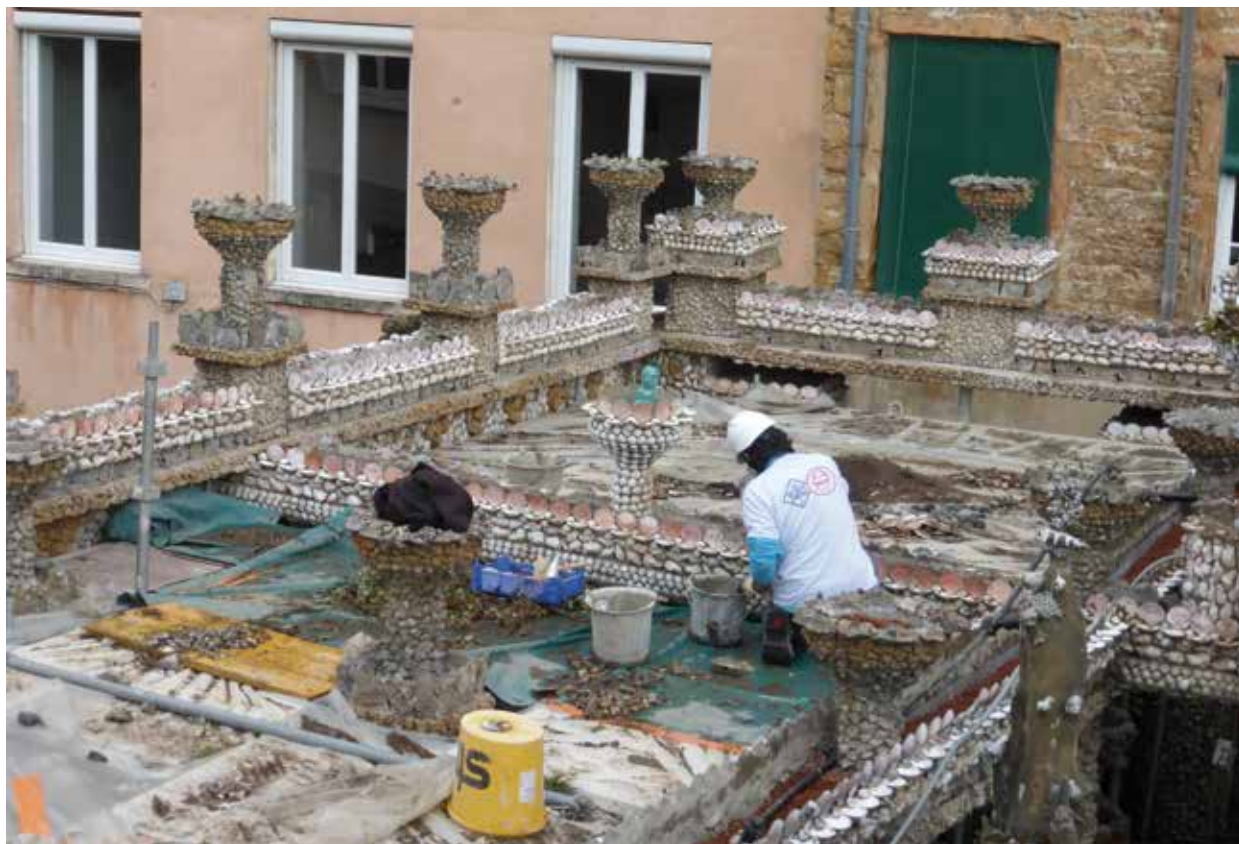
Restauration en cours des portiques du jardin, ornés de coquilles Saint-Jacques.
