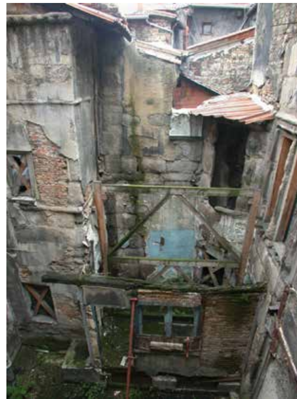
La cour intérieure de la Maison François I er avant restauration.
