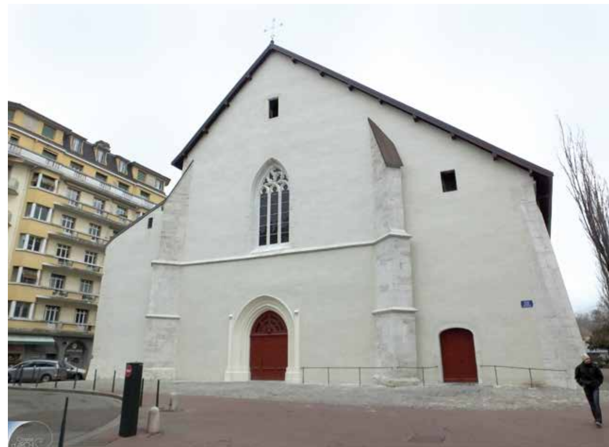
La façade occidentale de l'église Saint-Maurice après restauration.
