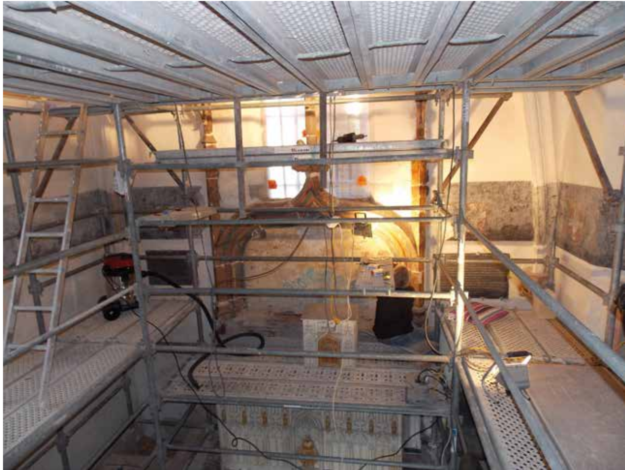
Église de Bouligneux, vue générale du chantier de restauration des enduits et peintures de la chapelle nord en 2014.
