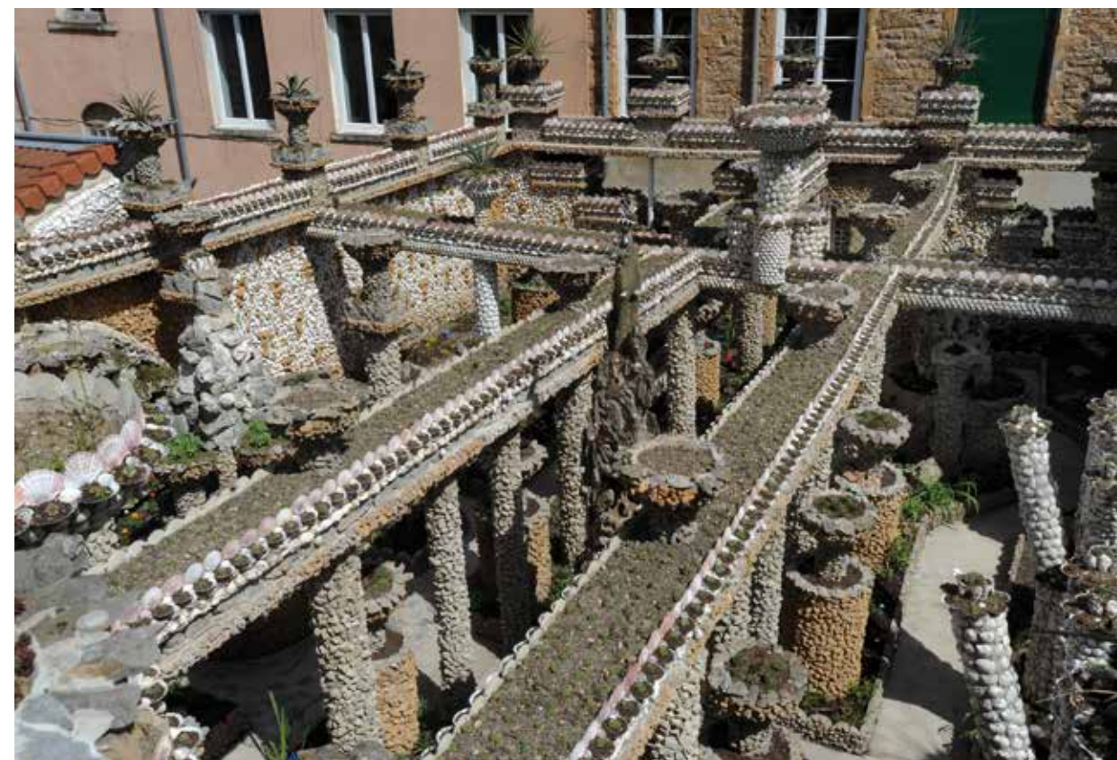
Vue générale des portiques restaurés.
