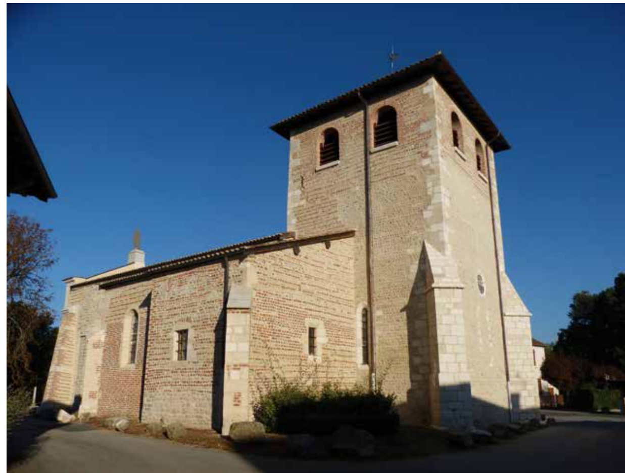
Église de Bouligneux, vue générale extérieure après restauration et suppression des enduits ciment.
