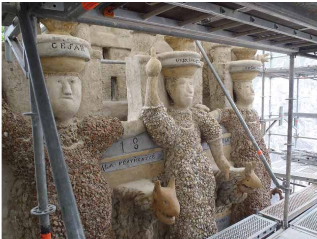
Le Palais en chantier : détail des figures baptisées par Ferdinand Cheval les « trois géants » : César, Vercingétorix et Archimède.
