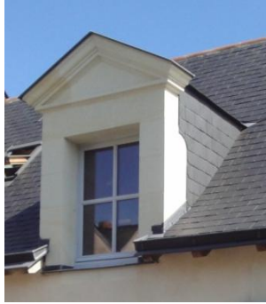
Lucarne à Bâtière : avec deux pans de couverture et fronton
