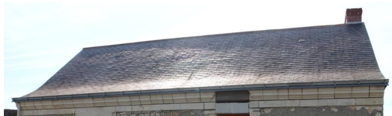
Toiture à 2 pans avec ligne de coyau
