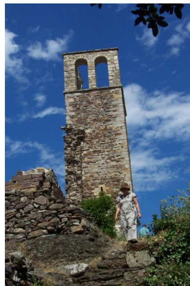
Neyran à Saint-Gervais-sur-Mare, © Maison Cévebole des ATP
