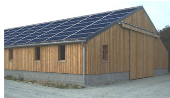
Image 1 : implantation de capteurs sur 100% de la couverture
