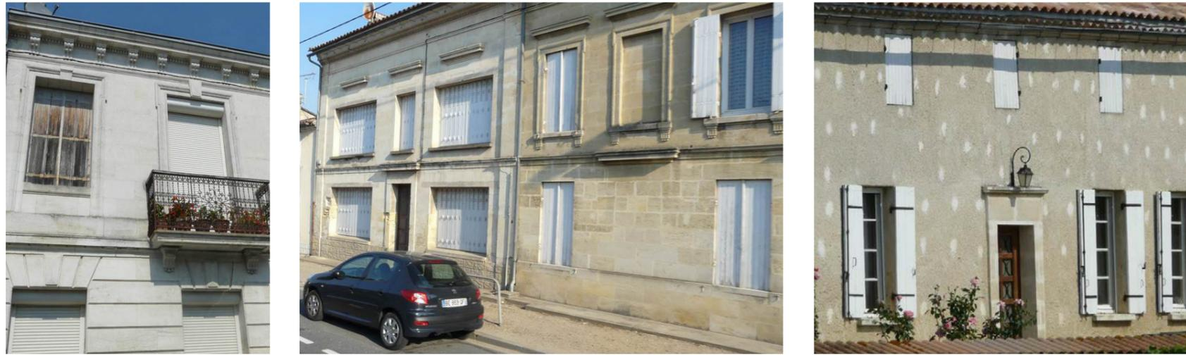
Des façades défigurées par les coffres des volets roulants, par la modification inadaptée des ouvertures, les enduits...
