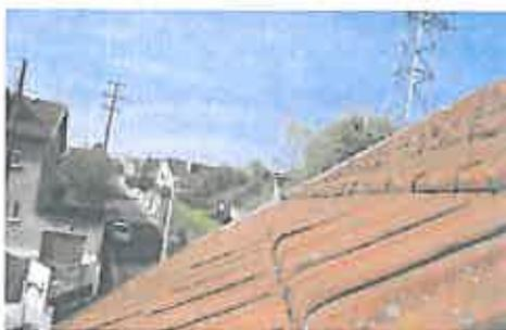
*Tuiles mécaniques (type Marseille)*
