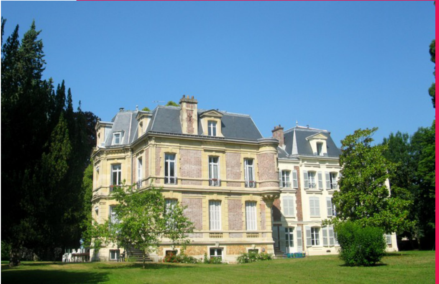
Château de la Martinière, Saclay © OTvalleedechevreuse91
