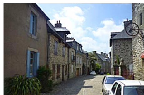
Cohérence des teintes entre enduits et pierres
