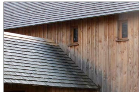
Couverture en ardoises
