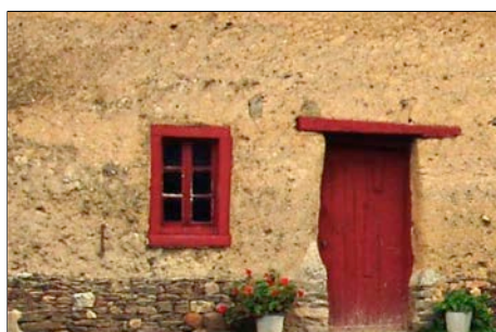
Maçonnerie en terre et soubassement en pierres
