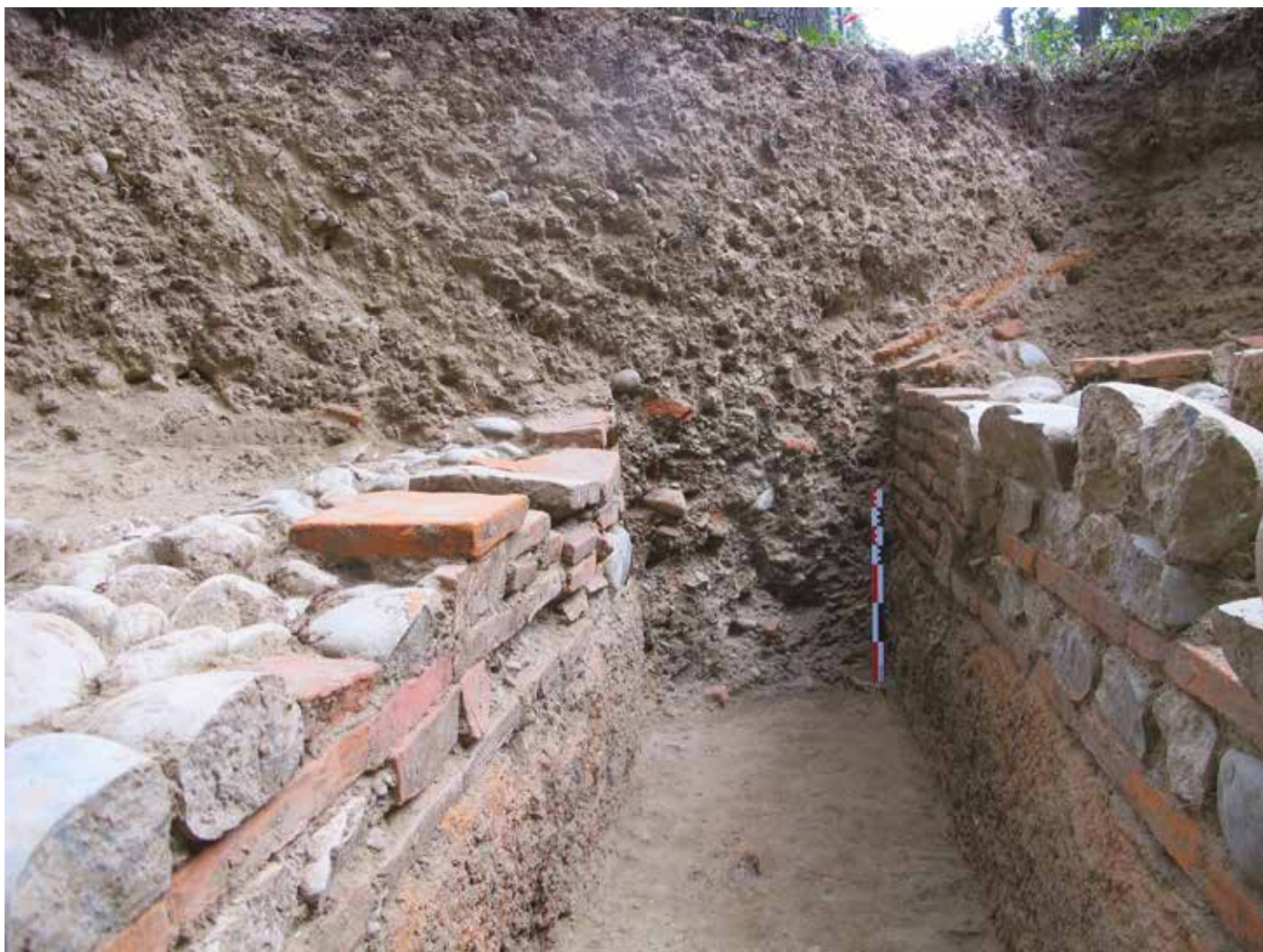
Toulouse, Reynerie, aqueduc. L'intérieur de la conduite vu depuis le nord avec, à droite, la réfection de la conduite et la naissance de la voûte (© SATM).
