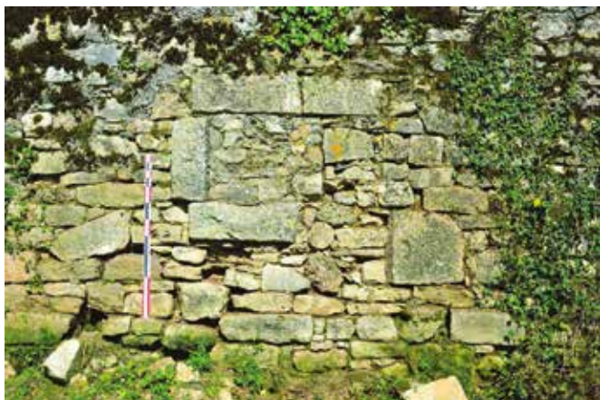
Bournazel, château. Chantepleure bouchée dans le mur divisant les jardins.
