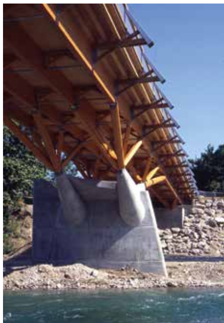
Crest (26), pont en bois (100 m).
