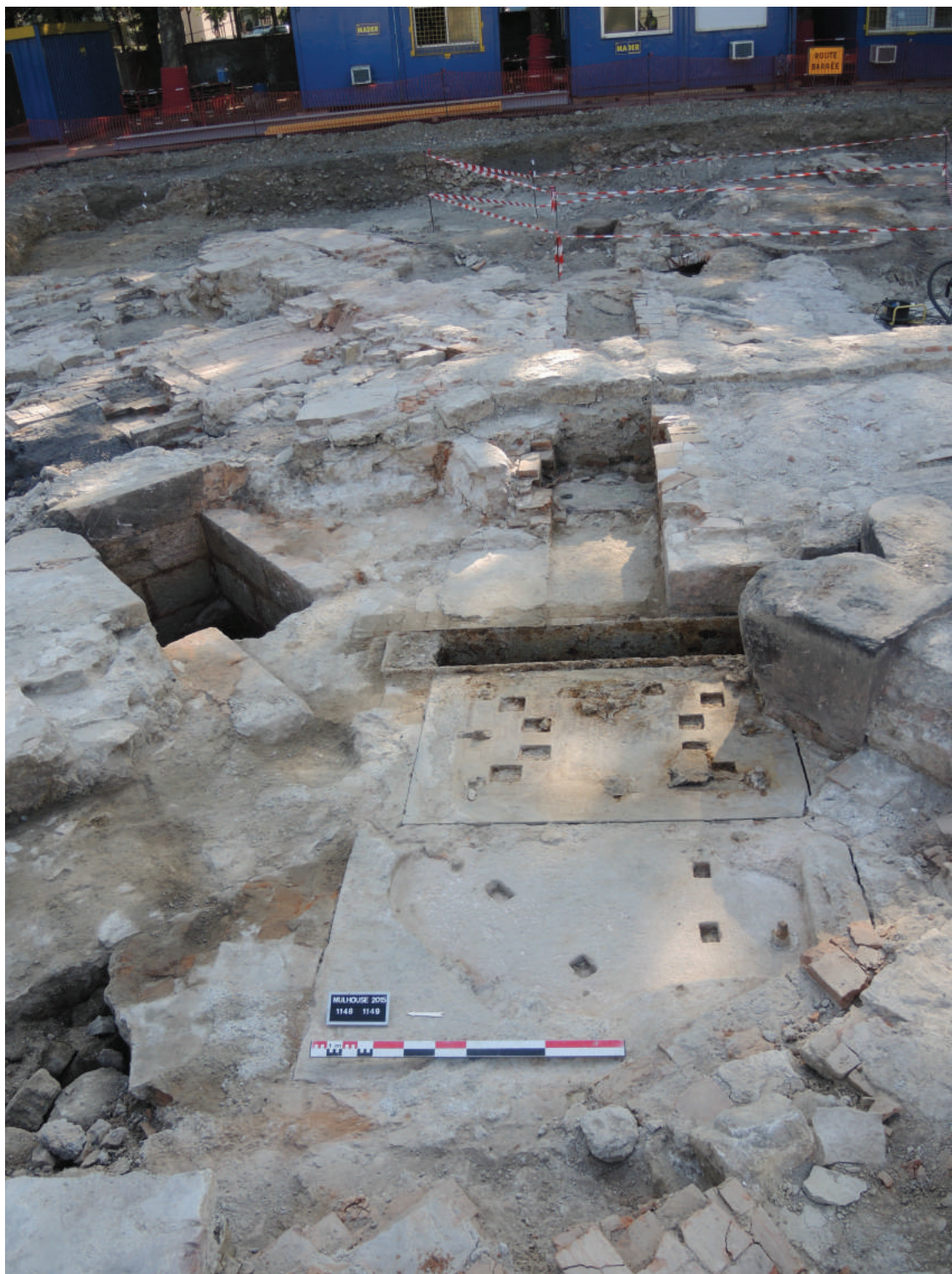
Fig. 2 : Socle d'une machine à vapeur verticale et cuve métallique destinée à accueillir un volant (milieu 19e s.).
