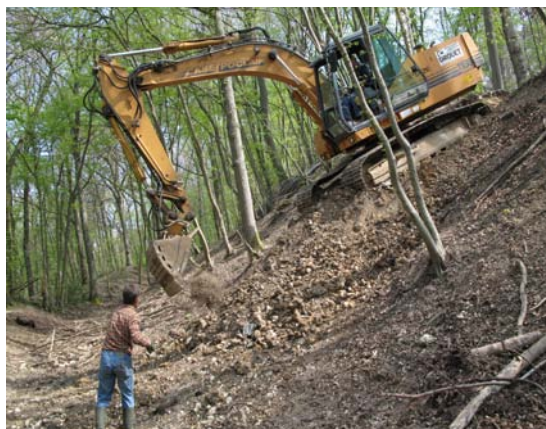
Remise en état du rempart de l' oppidum d'Orival (cl. L. Lévêque, ONF).
