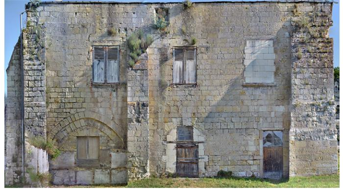
Fig. 5 : Façade sud de la partie occidentale de l'hôtellerie (orthophotographie ; à gauche : l'arc correspondant au passage voûté).
