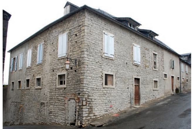
Façades ouest et sud de l'ancienne école Marie Elisabeth, à l'issue du décrépiçage.
