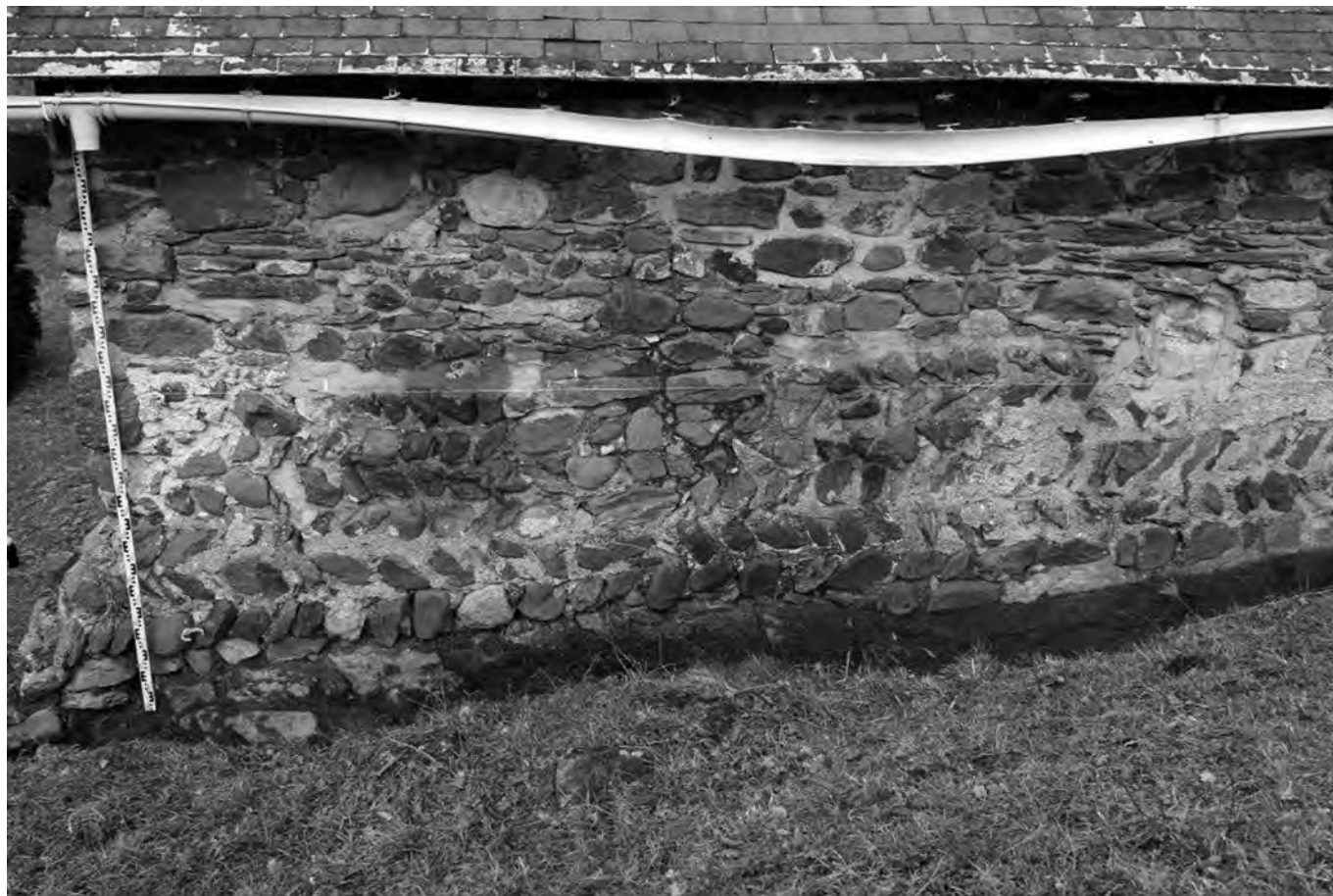
Borce Saint-Laurent, mur sud.
