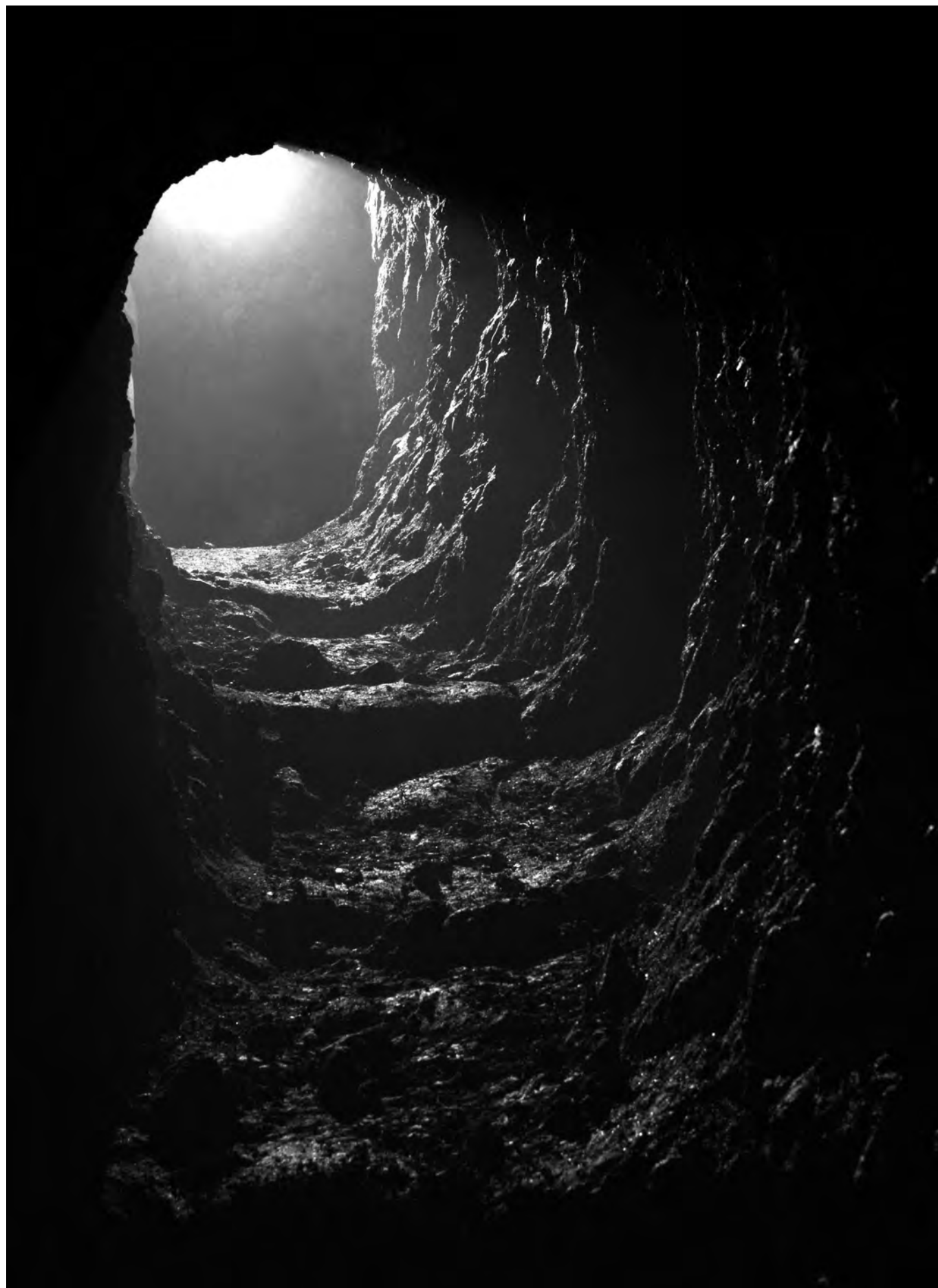
Banca - Mine de Mehatze : Galerie en descenderie, équipée de marches rudimentaires.
