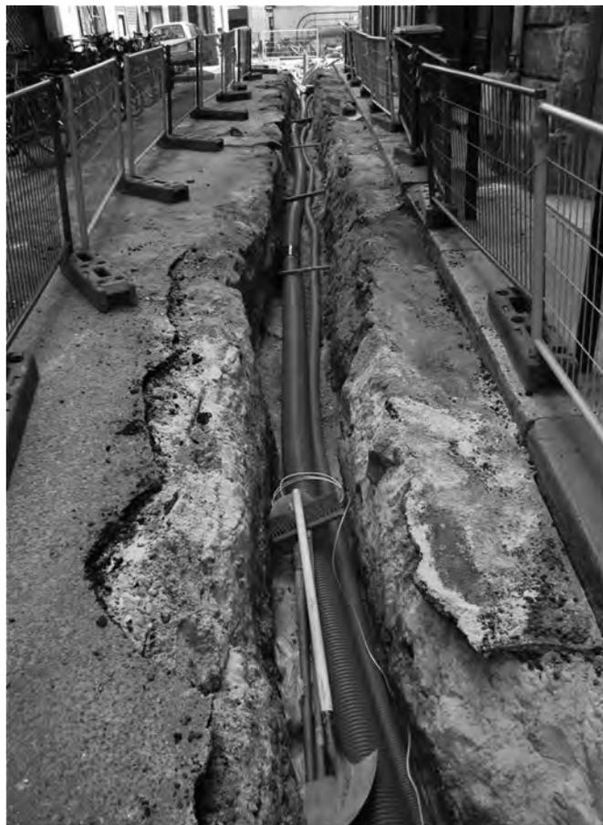
Figure a : Vue vers le sud tranchée réseau électrique.
