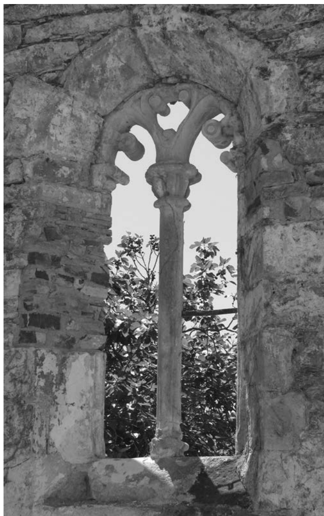
Baie de la façade sud du chevet.
