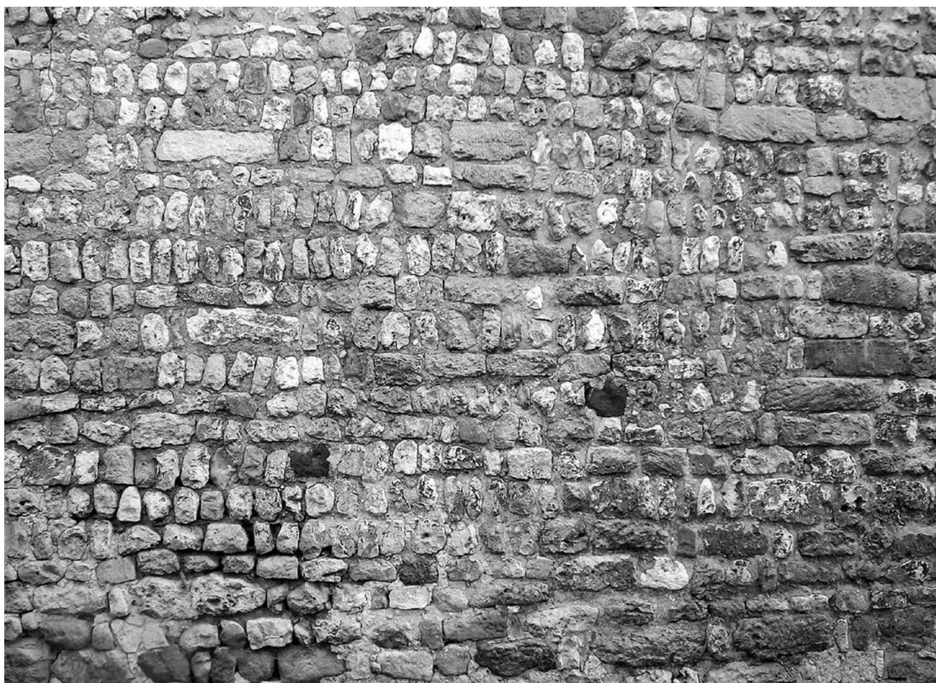
*Pressignac-Vicq - Eglise. Détail de la maçonnerie de moellons équarris du mur nord de la nef.*
