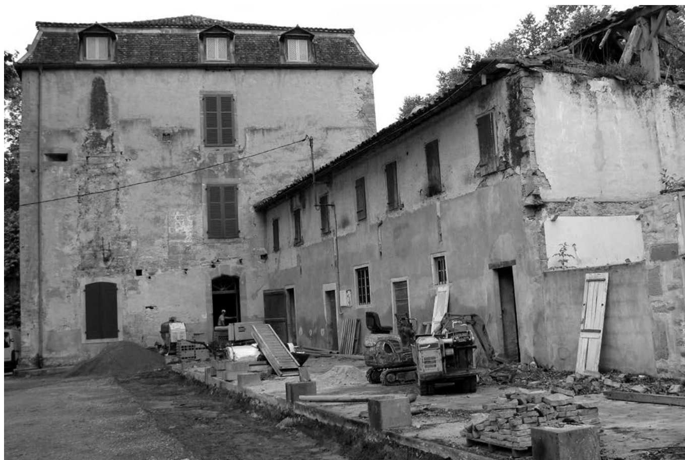
Façade nord de la maison forte et dépendances postérieures.
